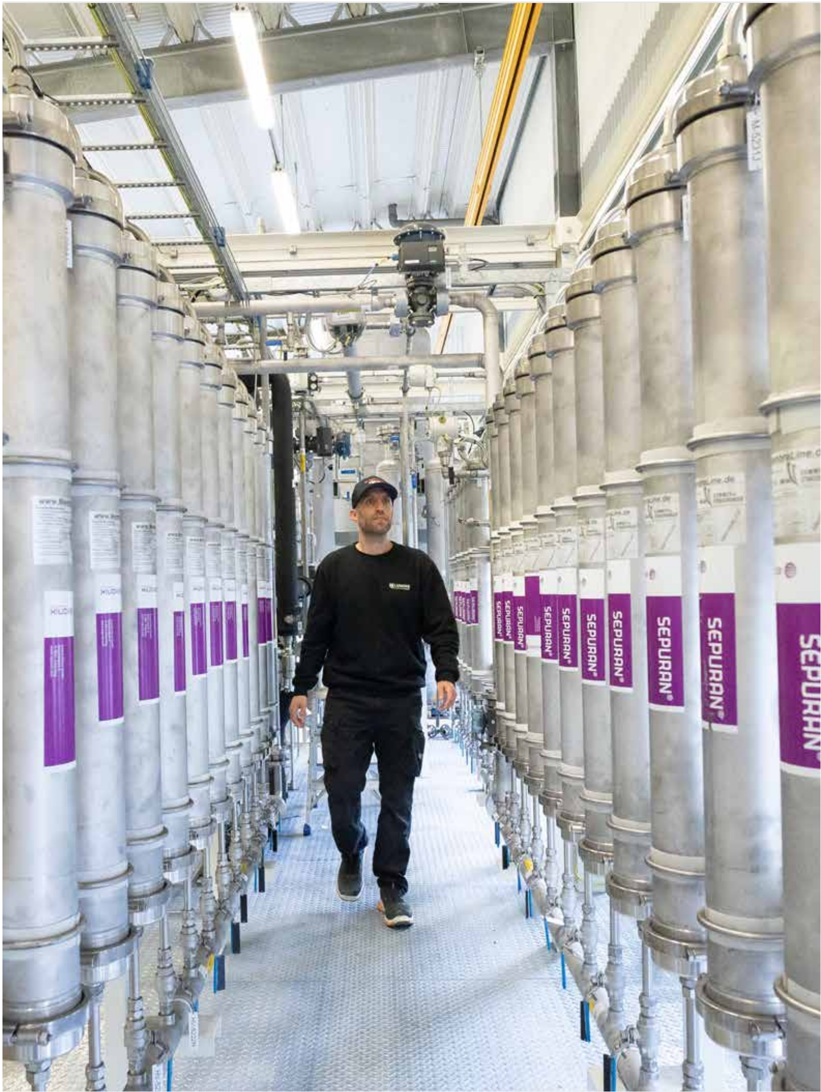
Inspektion av membran för biogasuppgradering
