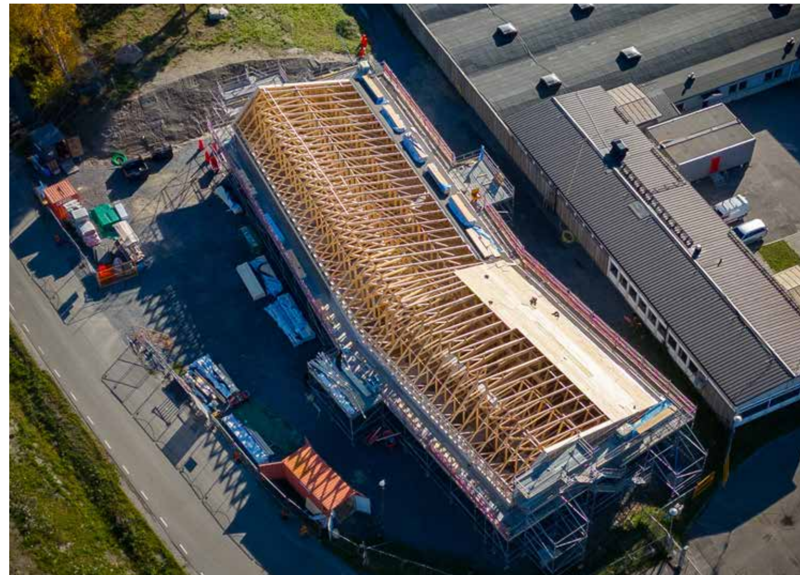
Bygget av Lumires nya personalbyggnad på Uddebo
