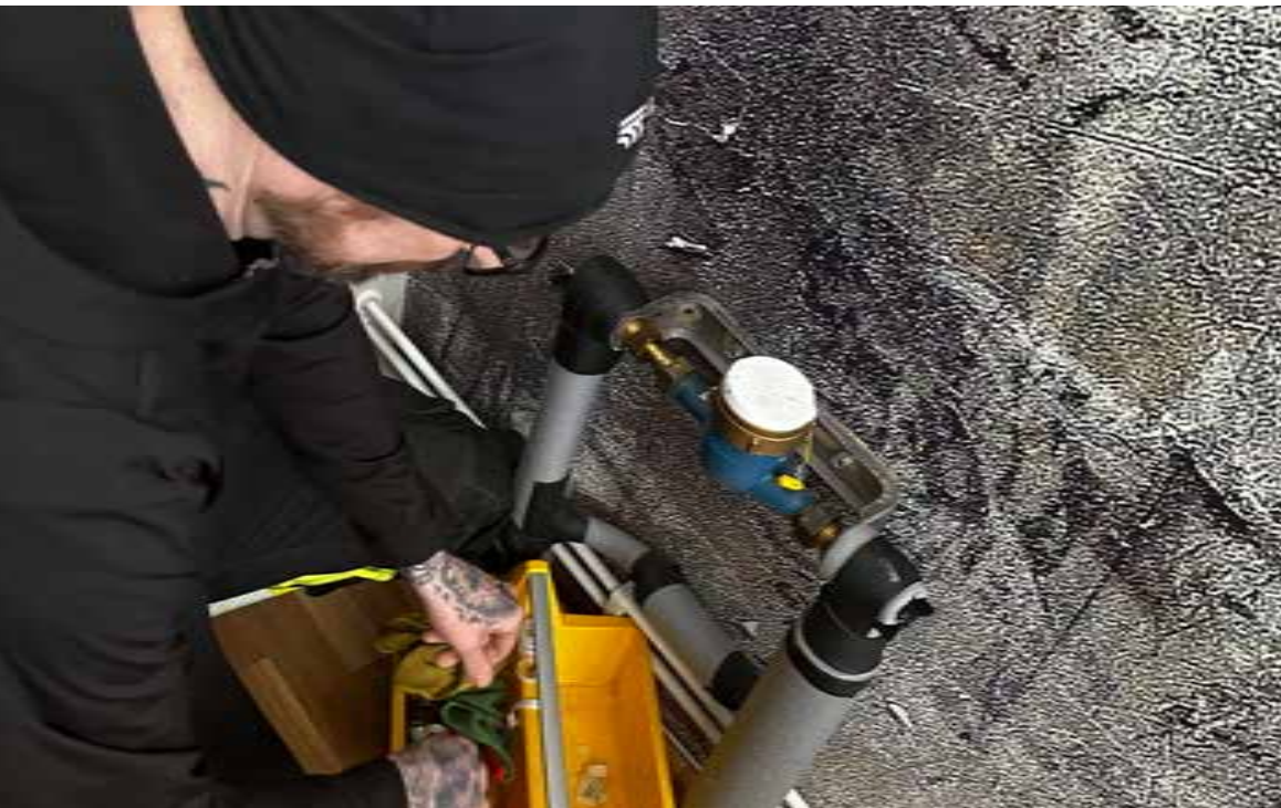
En digital vattenmätare installeras
