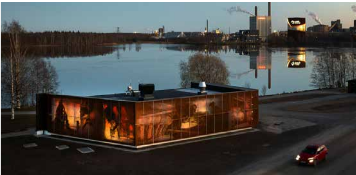
Hyttan, en konstnärligt utformad pumpstation, visar hur offentlig infrastruktur kan bidra till platsidentitet och stolthet.
