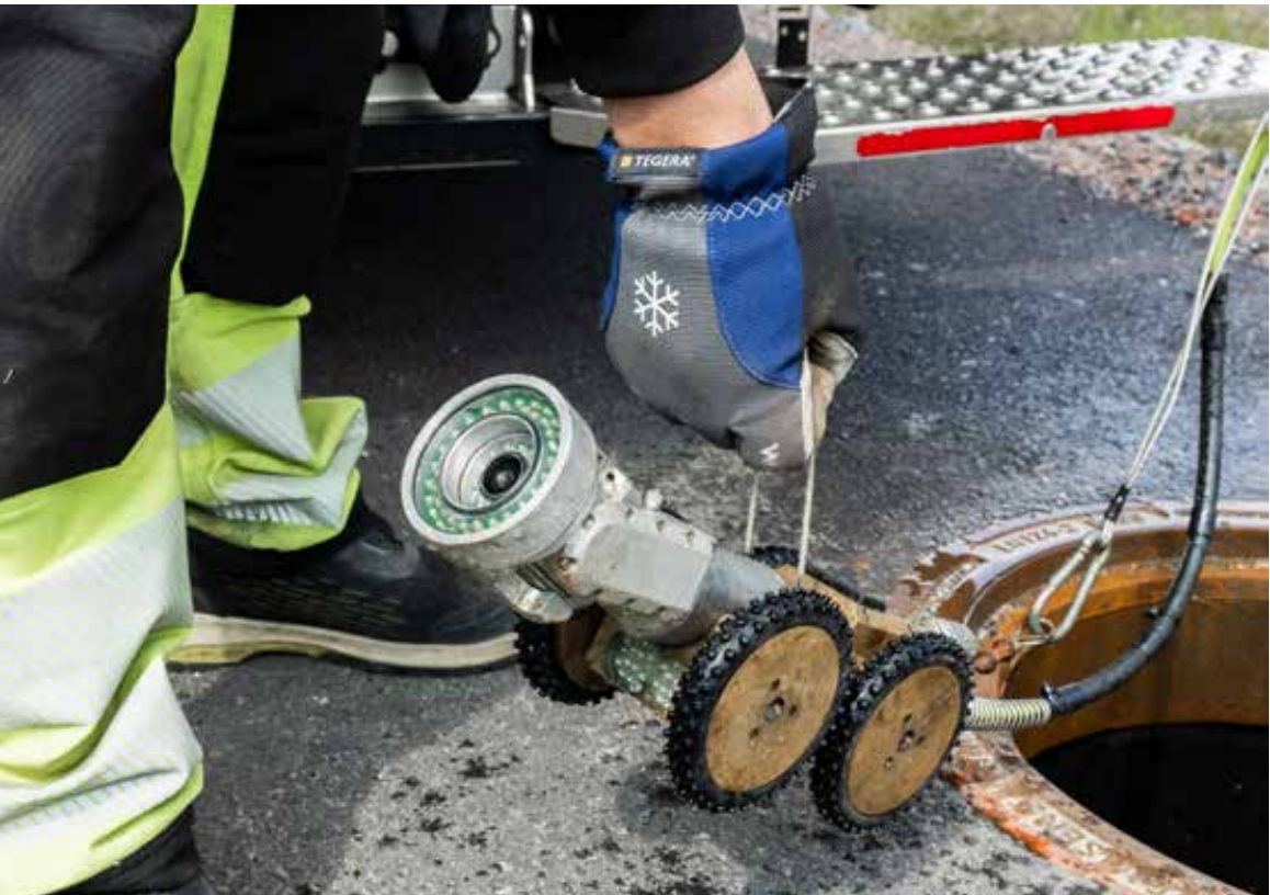
Filmning av spillvattenledning
