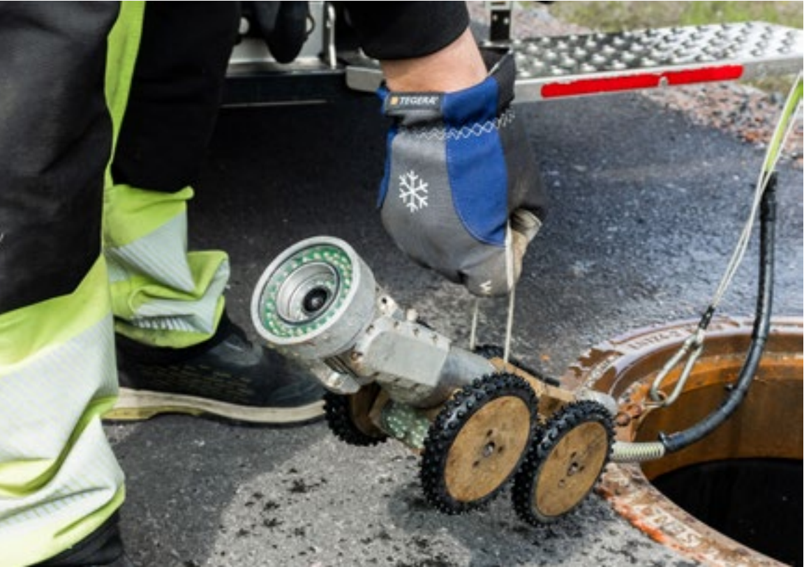
Filmning av spillvattenledning
