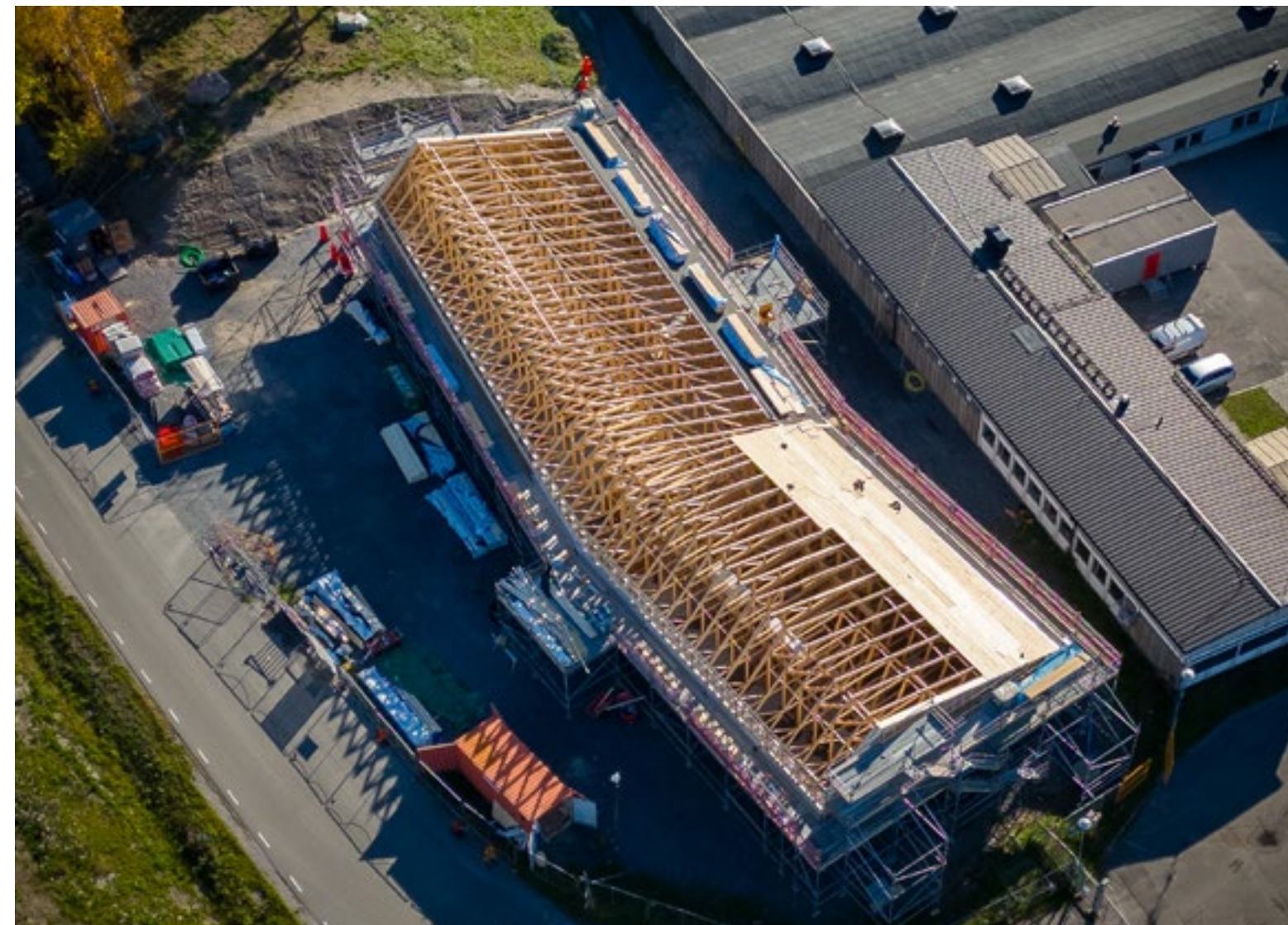
Bygget av Lumires nya personalbyggnad på Uddebo
