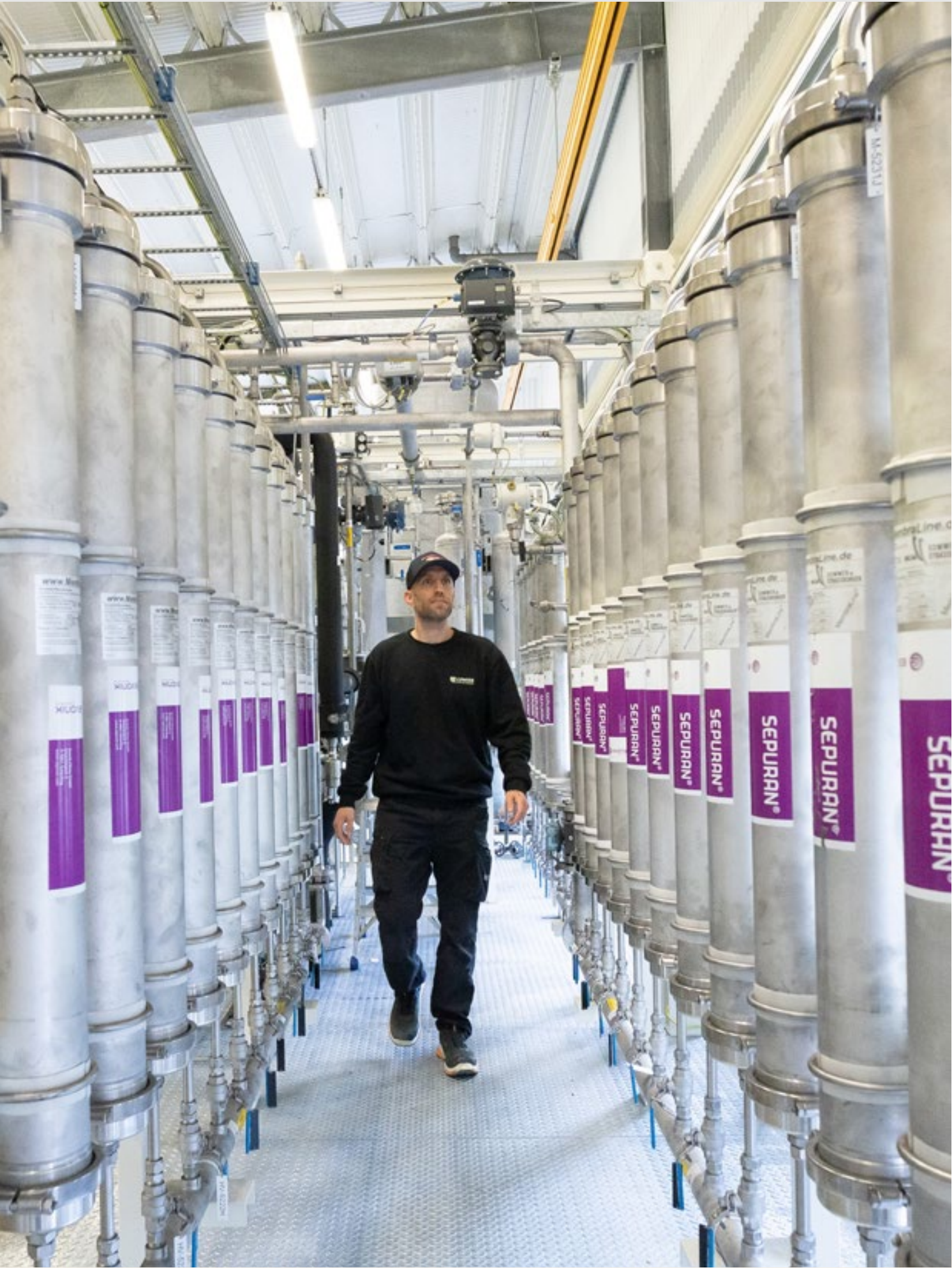
Inspektion av membran för biogasuppgradering
