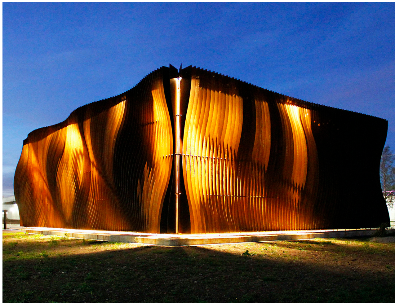
Pumpstation 42 vid Mjölkuddsbanken i Luleå. Foto Designat Ljus i Europa.
