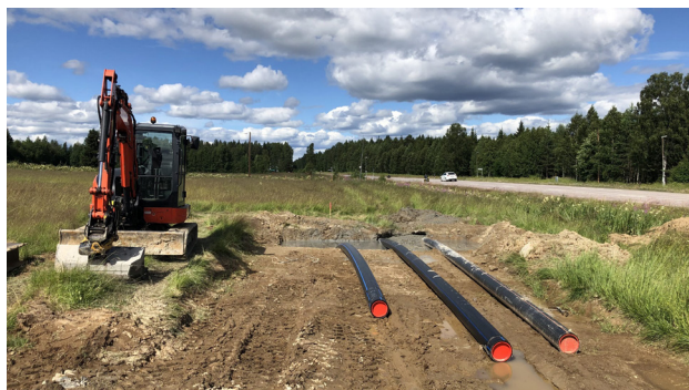
Pågående arbete med Råneå överföringsledning.
